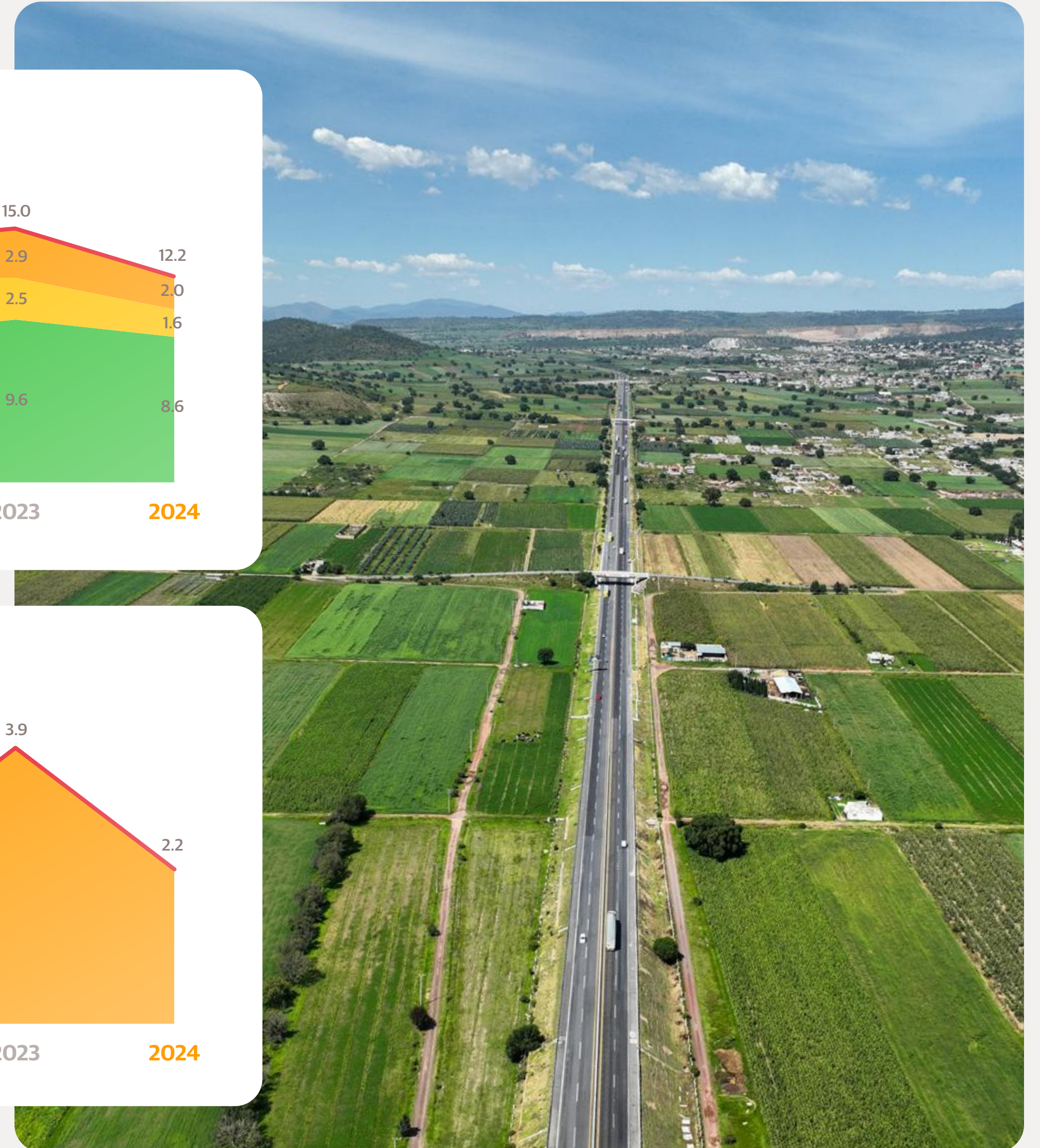
Circuito Exterior Mexiquense
