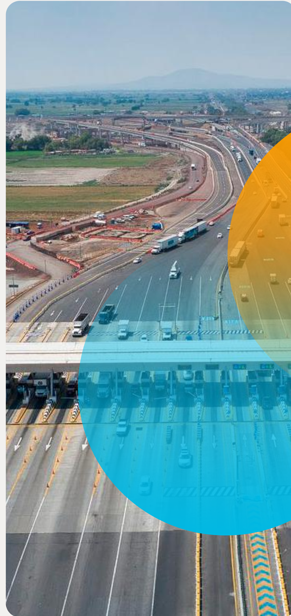
Circuito Exterior Mexiquense
