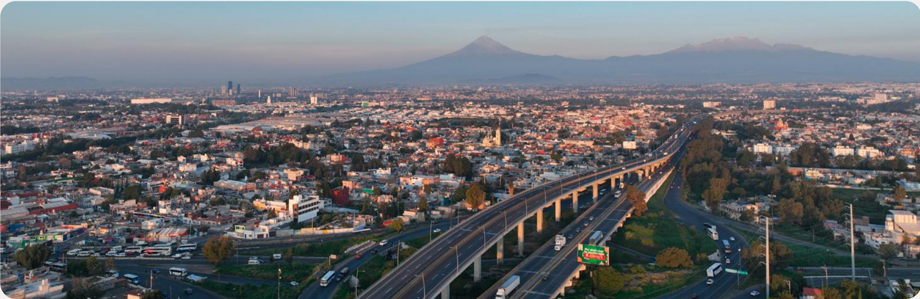
Libramiento Elevado de Puebla
