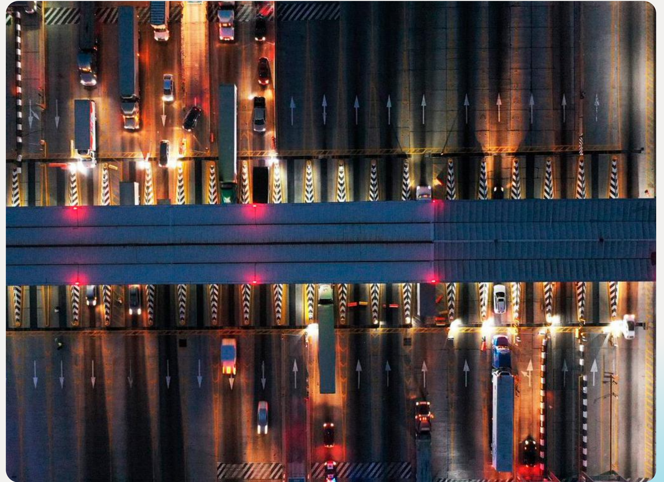
Circuito Exterior Mexiquense
