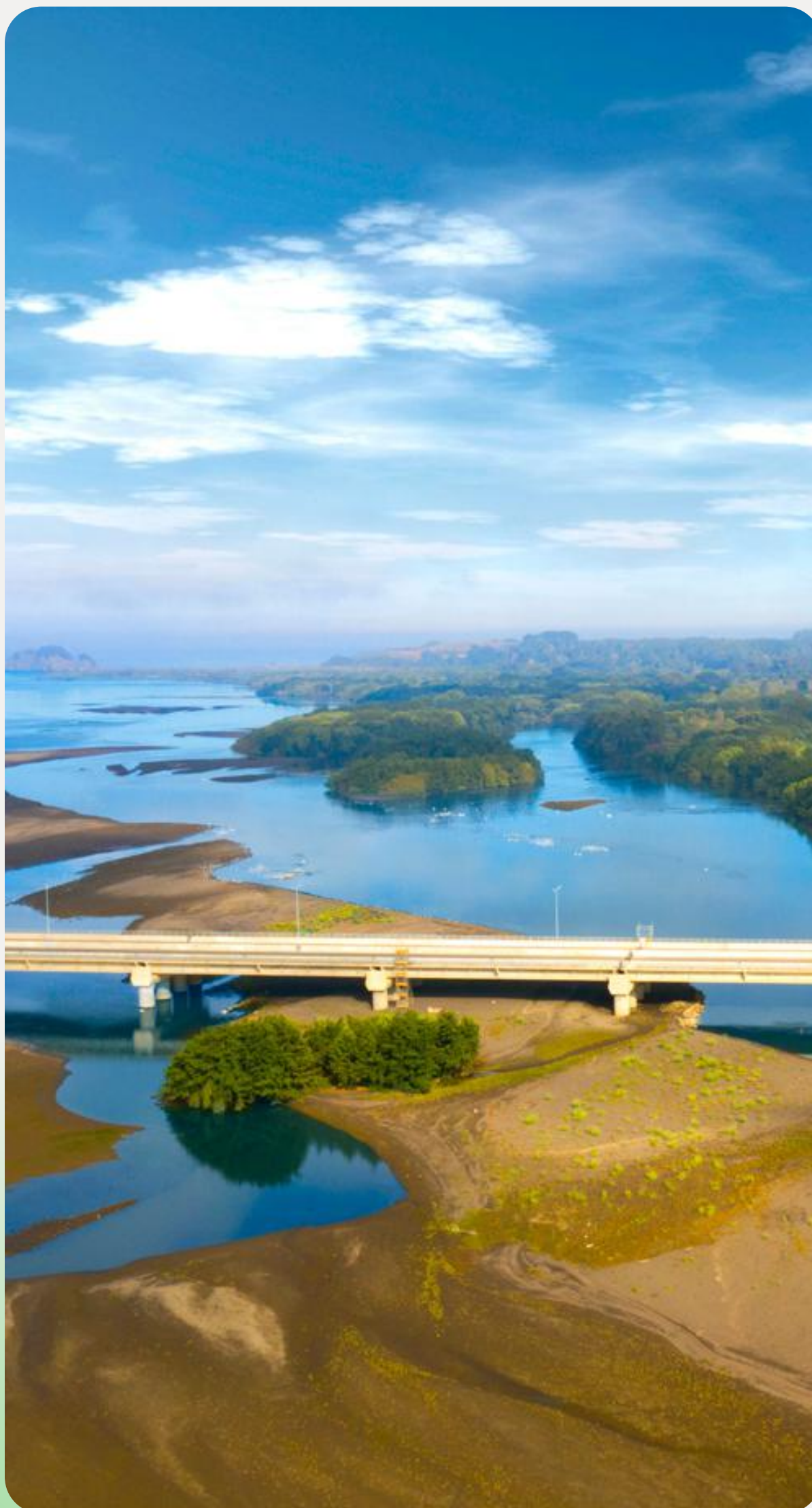
Puente Industrial, Chile.
