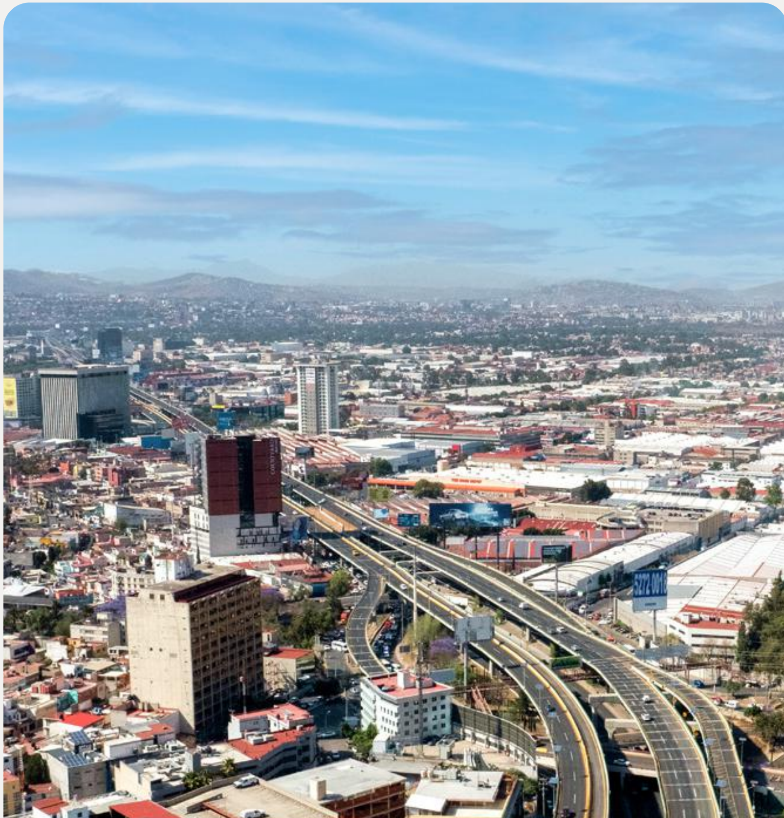
Viaducto Bicentenario, Mexico.
