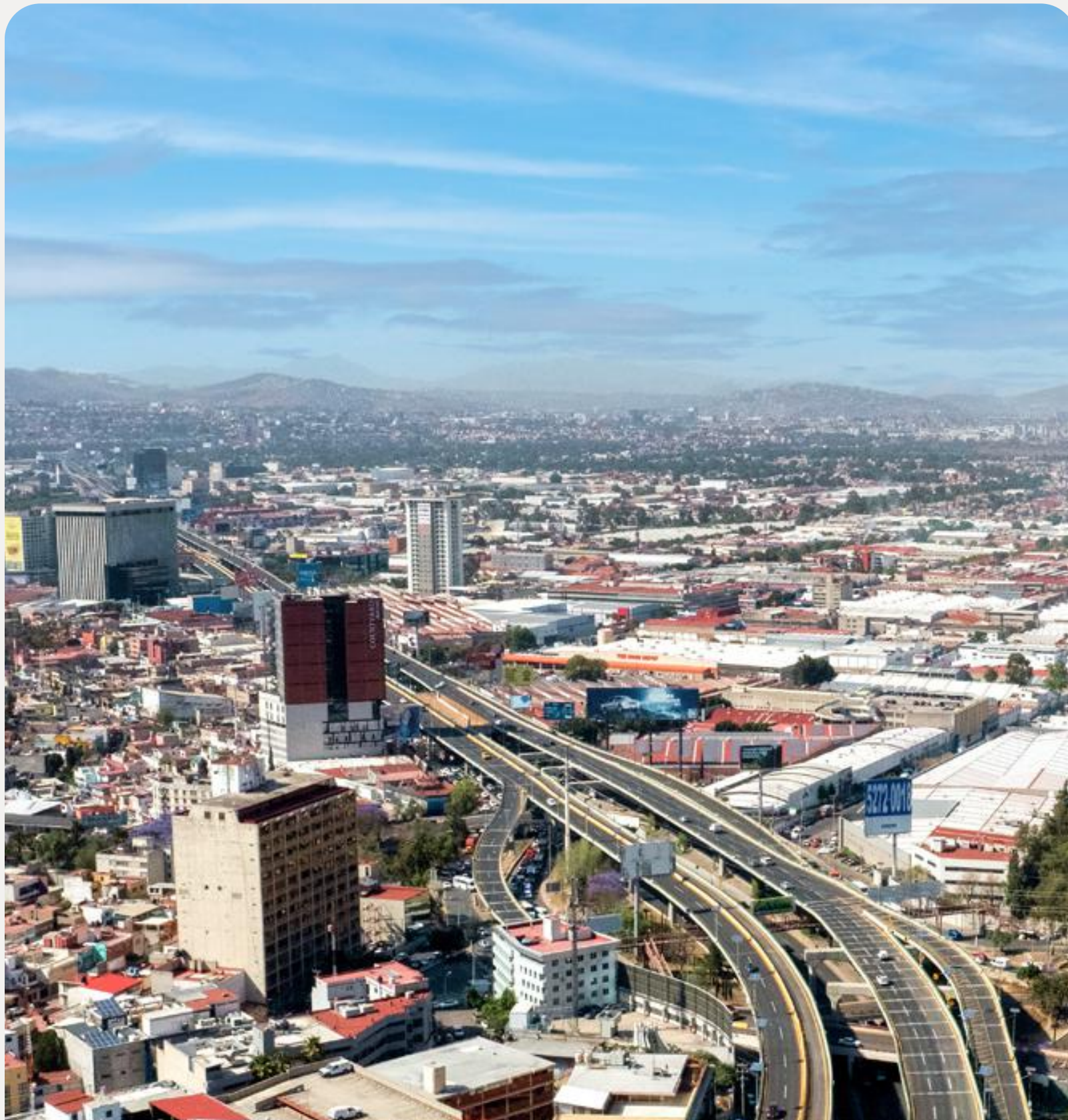
Viaducto Bicentenario, México.
