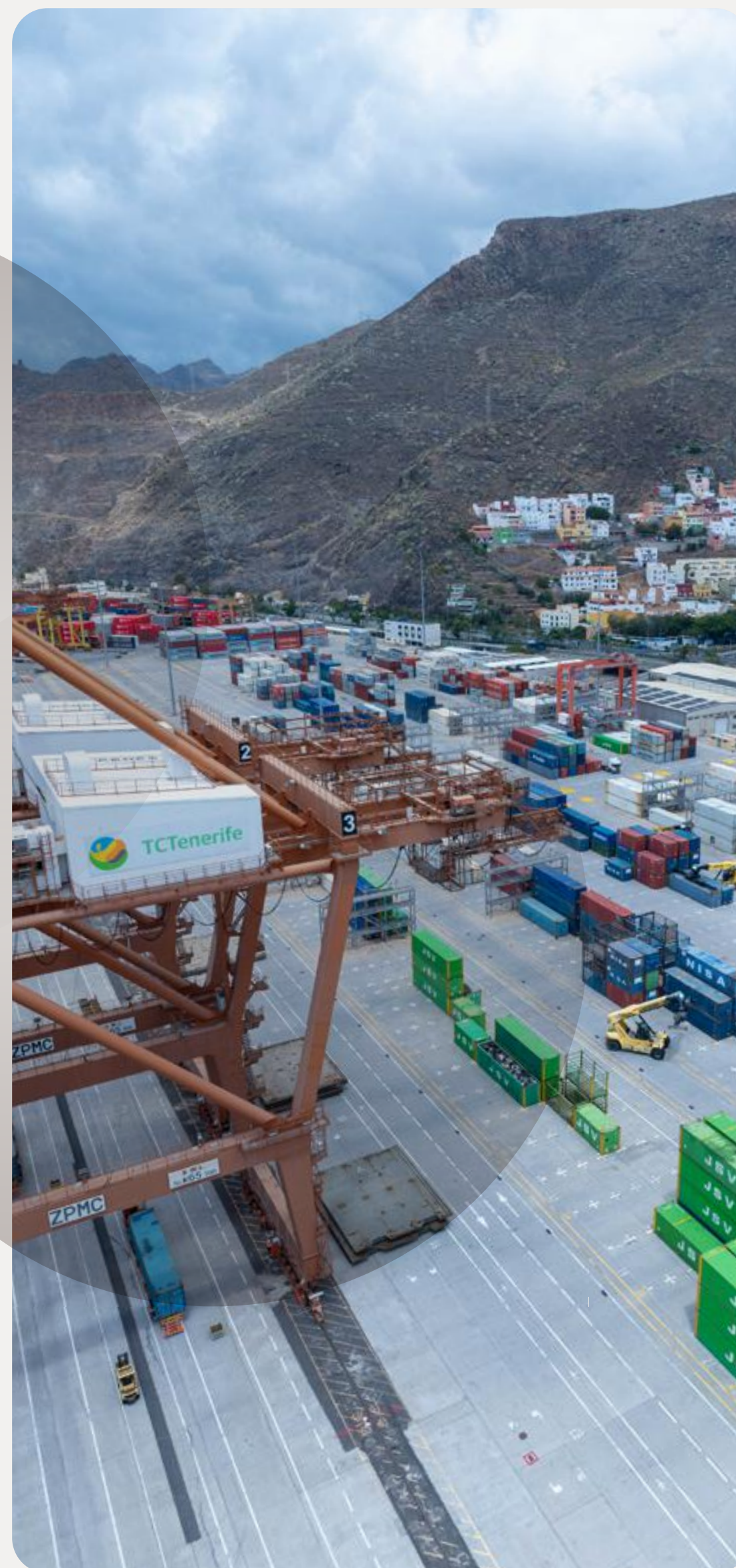
Terminal de Contenedores de Tenerife, España.
