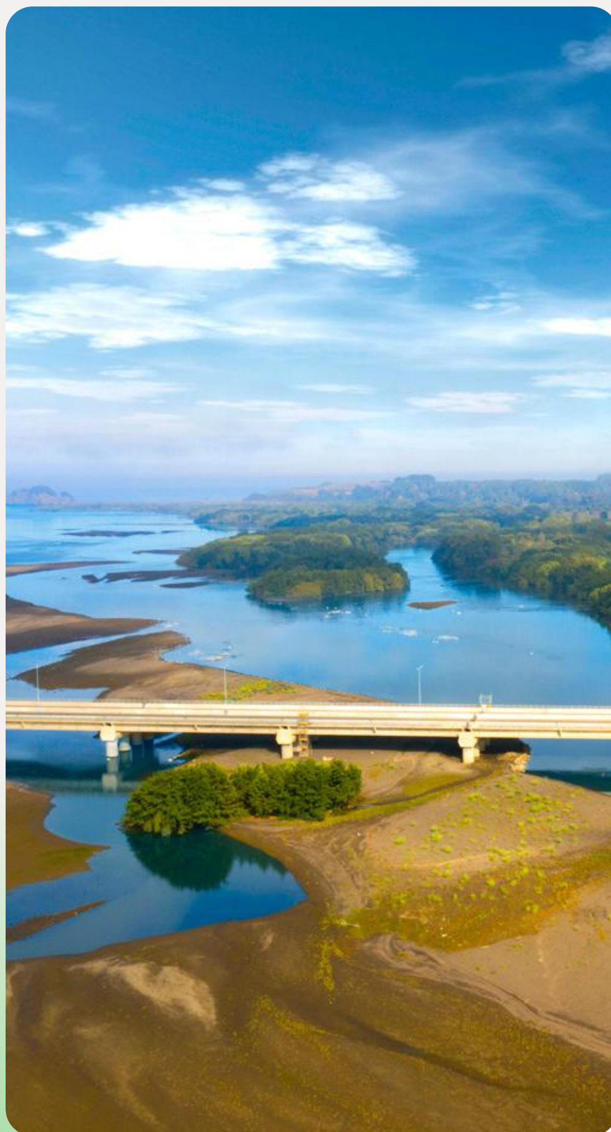
Puente Industrial, Chile.
