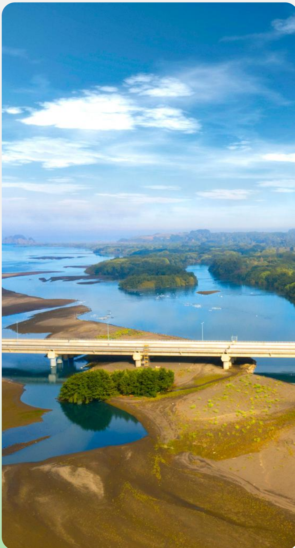
Puente Industrial, Chile.
