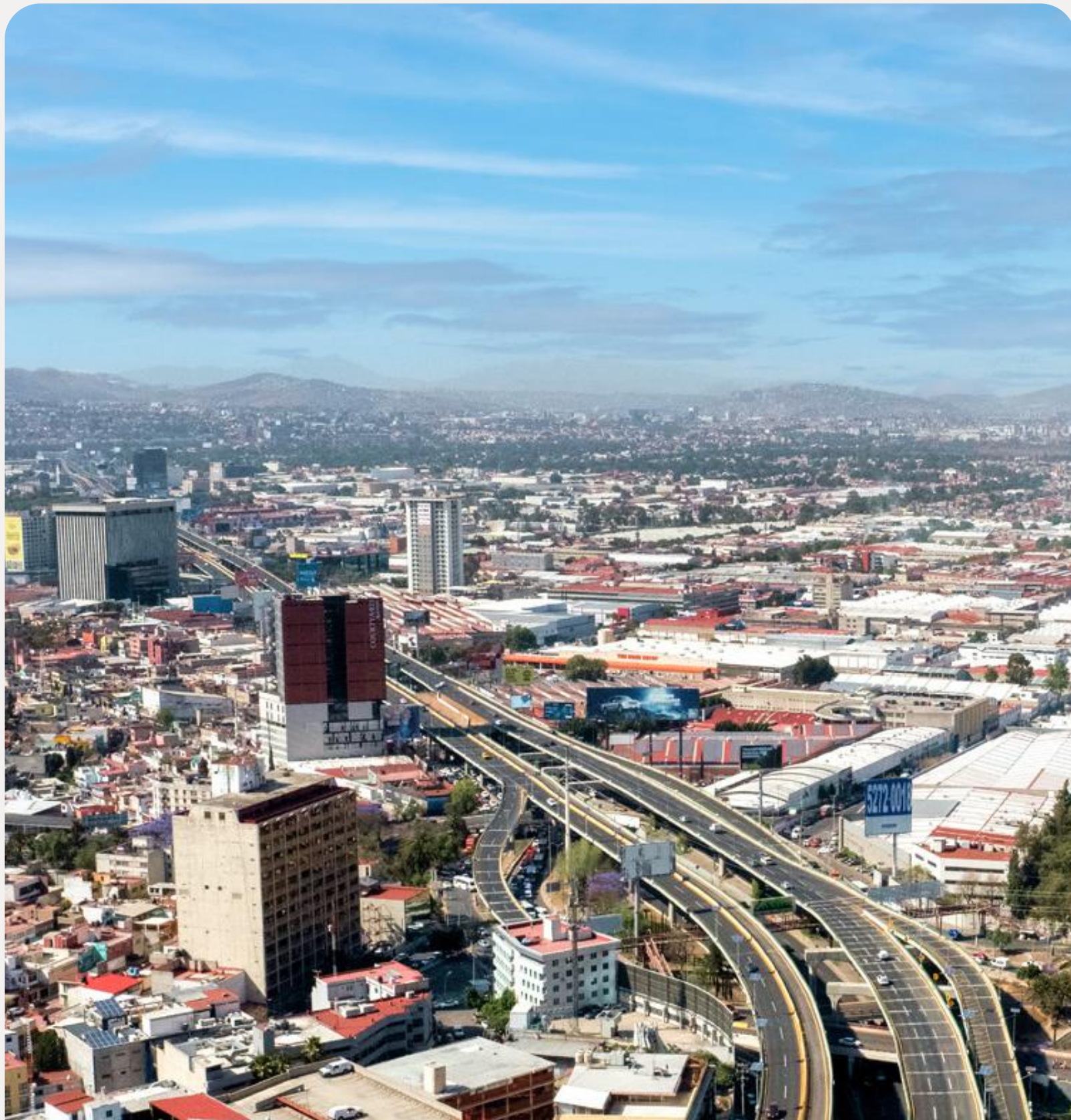
Viaducto Bicentenario, Mexico.
