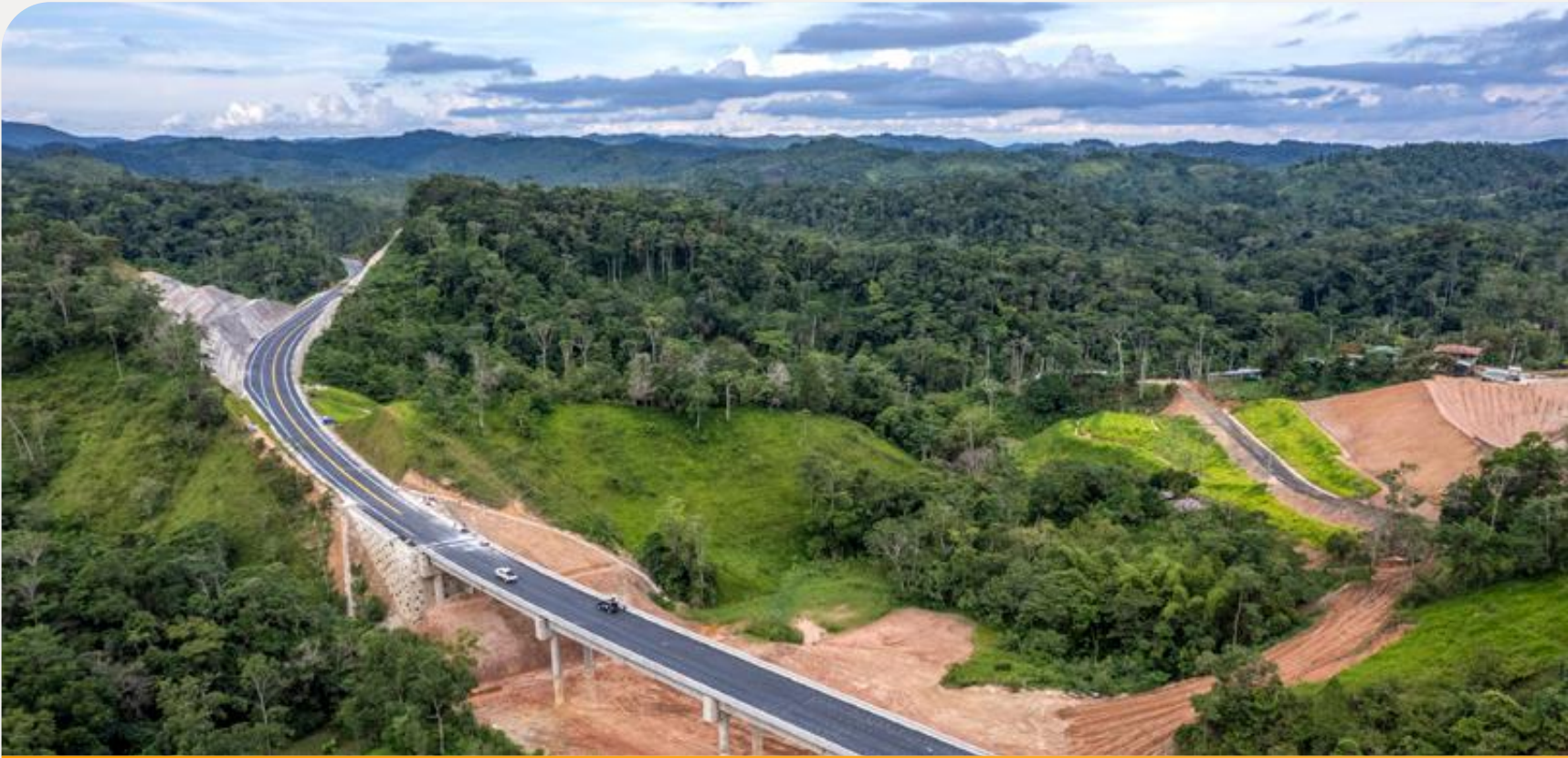
Autopista Río Magdalena, Colombia.
