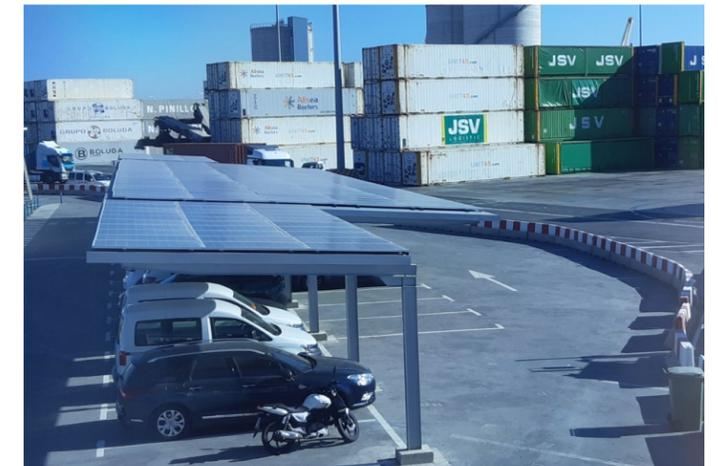
En Puerto Alicante se realizó la instalación de 120 paneles, otorgando un total de potencia instalada de 64,2 kW. La estimación de producción anual de la instalación está prevista en 58.350 kwh, lo que equivaldría a 16 ton de CO2 equivalente. Esta instalación complementa a las dos instalaciones fotovoltaicas que fueron instaladas en años anteriores. Con el nuevo montaje se pretende alcanzar el 10% de la energía consumida por las instalaciones.
